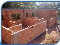
Construção Chácara Lageadinho – Ibiúna - SP
