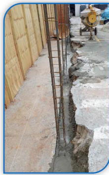
Construção de Muro Estruturação Broca Baldrame Jardim São Caetano SCS
