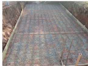
Construção de Piscina Baldrame / Ferragem Bairro Lageadinho - Ibiúna - SP
