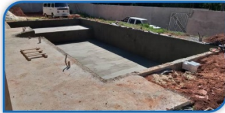
Construção de Piscina Alvenaria Bairro Lageadinho - Ibiúna - SP
