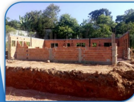
Construção Chácara Lageadinho – Ibiúna - SP
