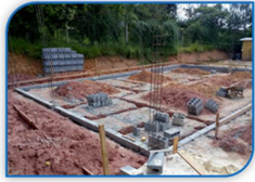
Construção Chácara Nivelamento e Levantamento com Bloco Lageadinho – Ibiúna - SP
