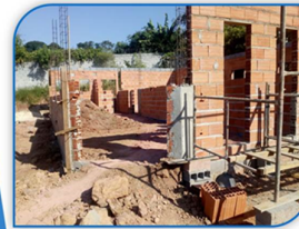
Construção Chácara Lageadinho – Ibiúna - SP
