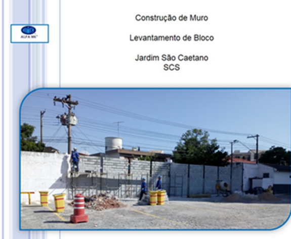
Construção de Muro Levantamento de Bloco Jardim São Caetano SCS
