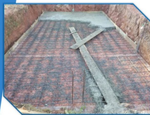
Construção de Piscina Concretagem Bairro Lageadinho - Ibiúna - SP
