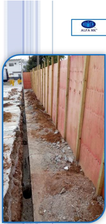
Construção de Muro Estruturação Broca Baldrame Jardim São Caetano SCS
