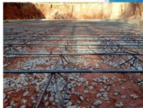
Construção de Piscina Baldrame / Ferragem Bairro Lageadinho - Ibiúna - SP
