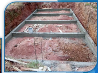
Construção de Piscina Estruturação Vigamento Bairro Lageadinho - Ibiúna - SP
