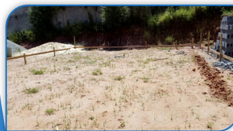
Construção Chácara Demarcação Baldrame Lageadinho – Ibiúna - SP
