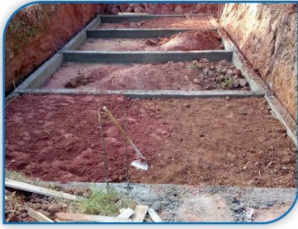
Construção de Piscina Aterramento Bairro Lageadinho - Ibiúna - SP
