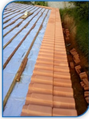
Construção Chácara Instalação Telhado 2 Aguas Lageadinho - Ibiúna - SP
