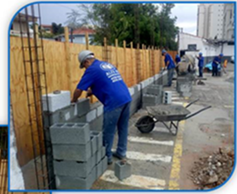
Construção de Muro Levantamento de Bloco Jardim São Caetano SCS
