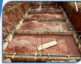
Construção de Piscina Estruturação Vigamento Bairro Lageadinho - Ibiúna - SP
